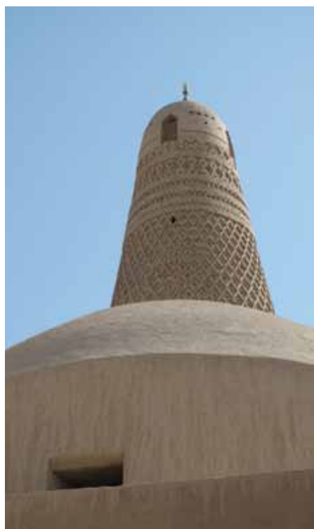
Abb. 5-1 Teil des Emin-Minarett und Moschee in Turfan. Photo: Chen, Pu. April 2012
