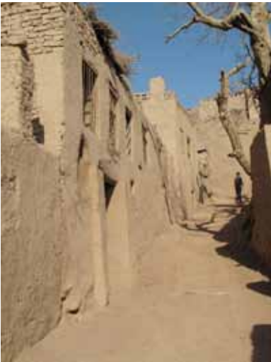
Abb. 5–15 uigurisches Khaki-Wohnhaus in Toyuq. Photo: Chen, Pu: April 2012
